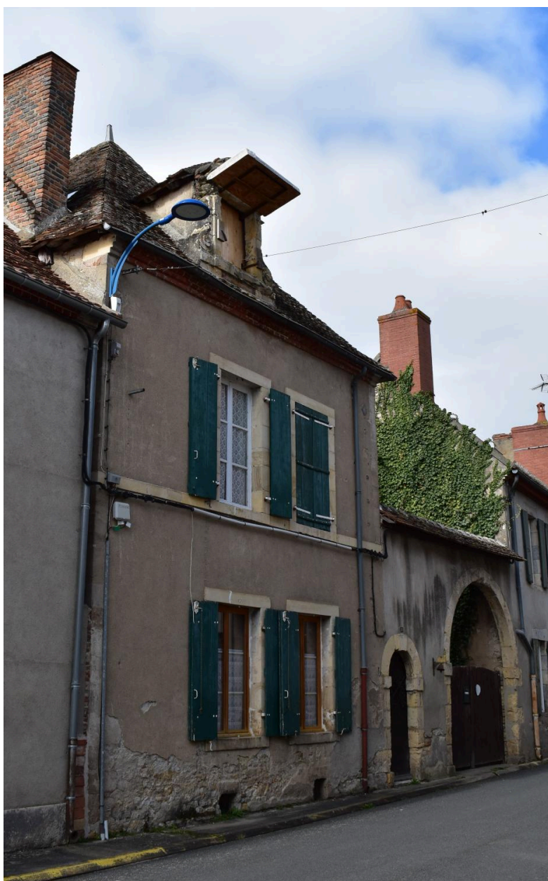
Vue générale de la façade latérale sur rue.
