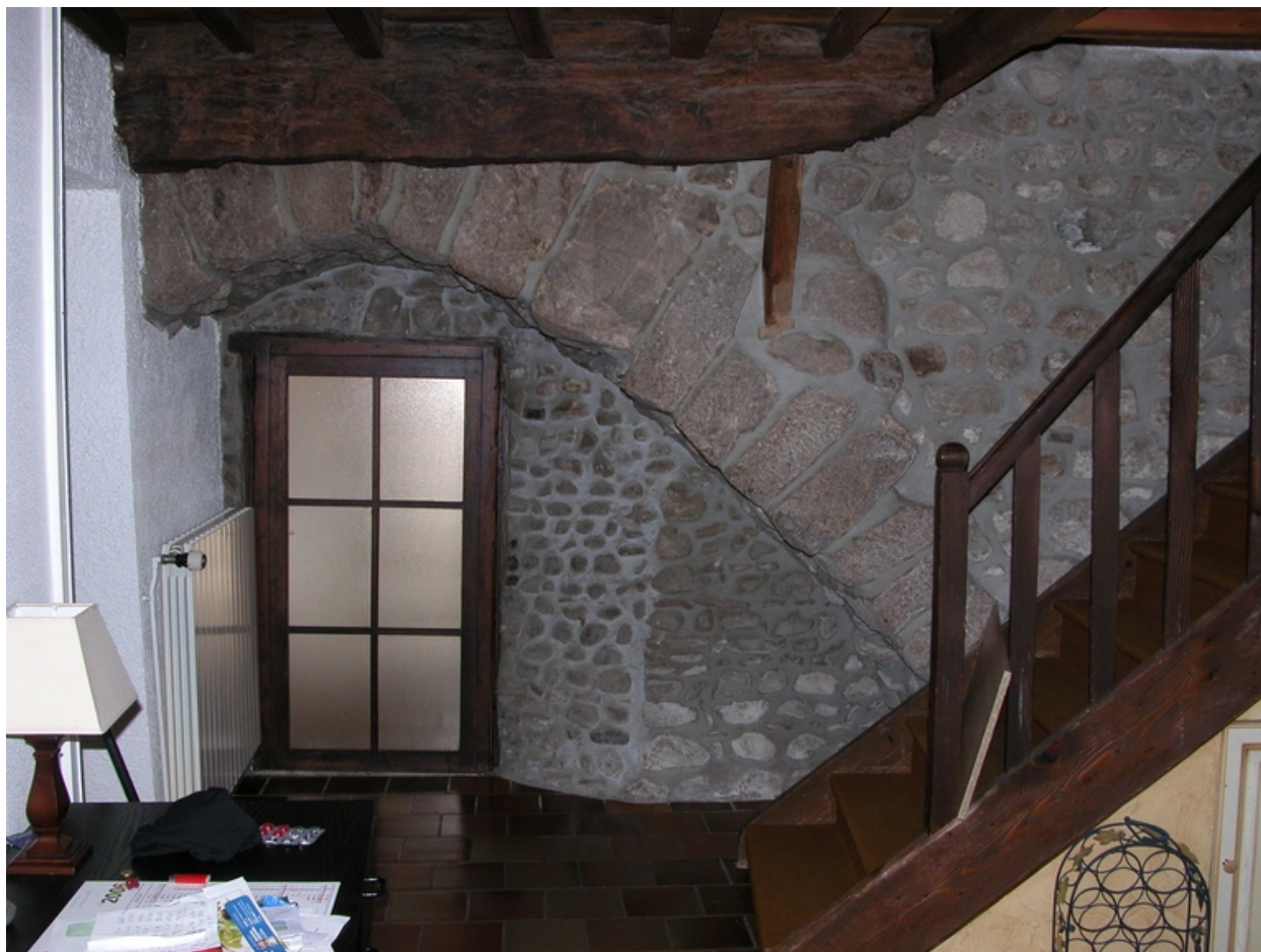
Le Bourg, rue Bégonnet-Biron. Maison. (1999 AD 117). Vestige de l'enceinte au rez-de-chaussée.
