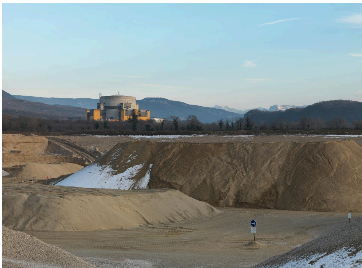
Centrale nucléaire de Creys-Malville
