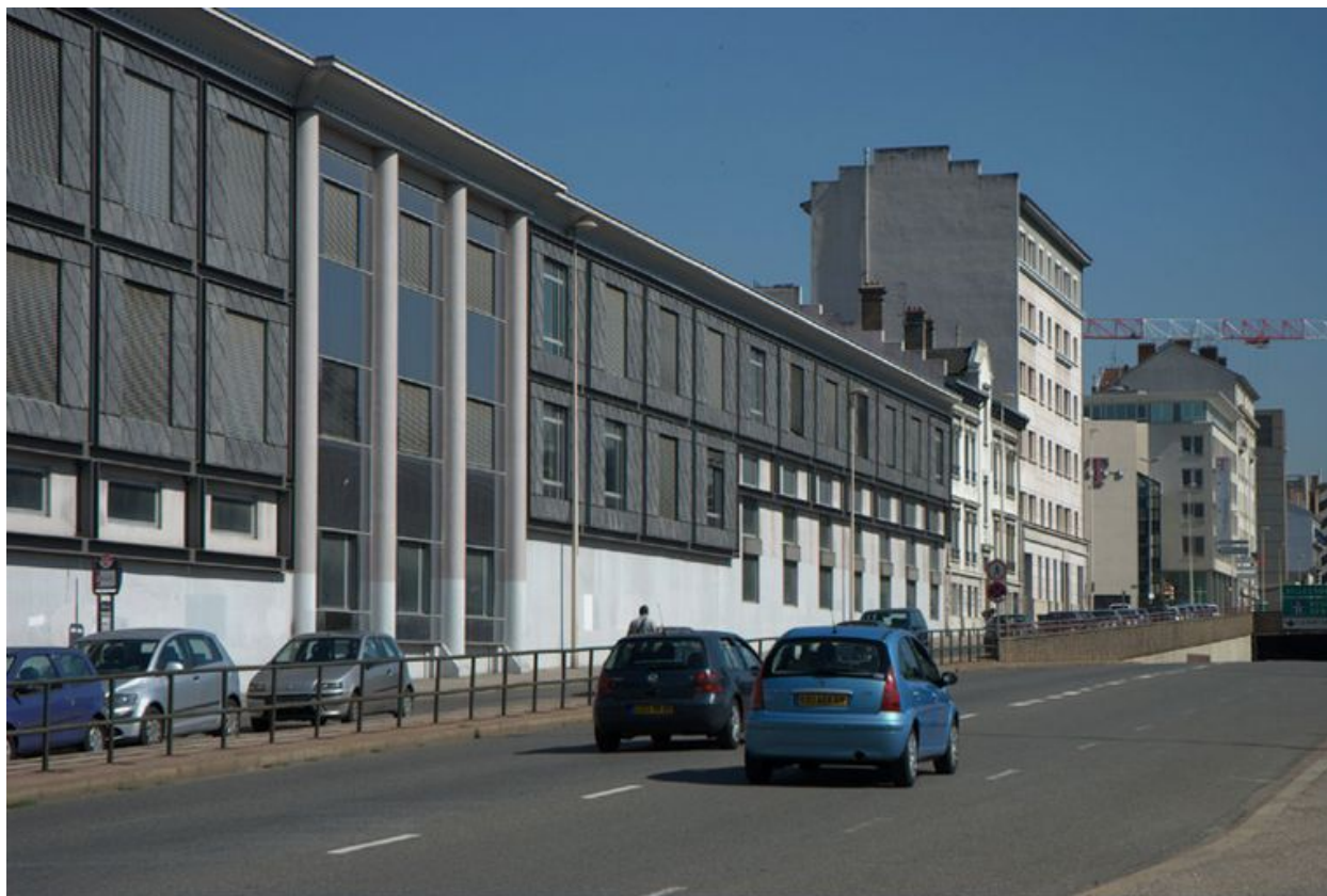
Elévation latérale, boulevard des Tchécoslovaques, depuis le sud-est
