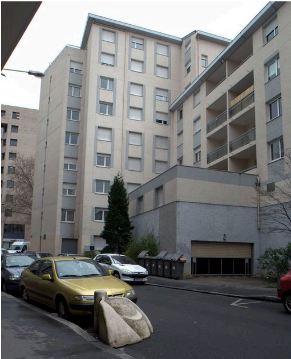
Elévation postérieure, vue partielle
