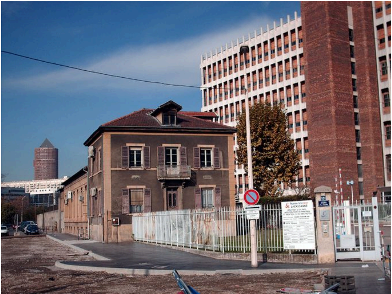
Vue d'ensemble de l'ancien bâtiment administratif de la société Marmonier
