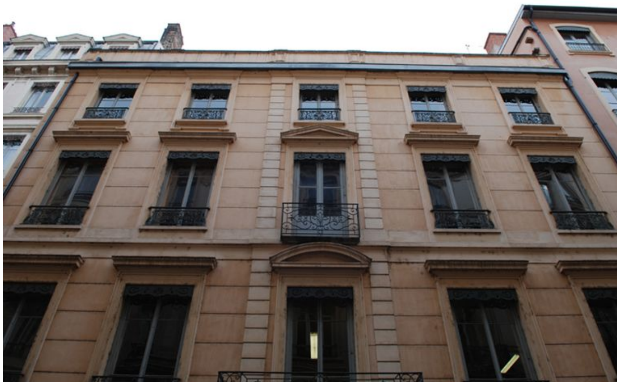
Elévation antérieure, vue partielle
