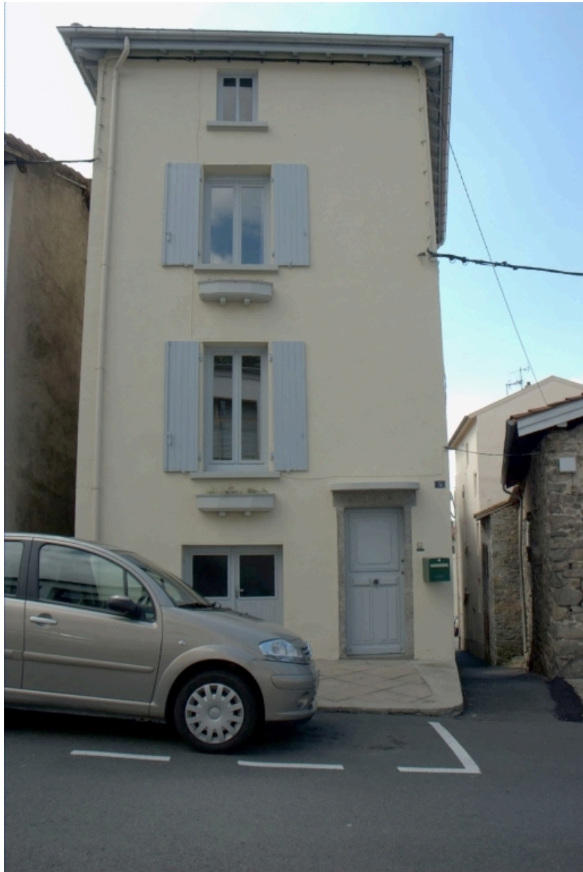
Îlot 3. Sordet (rue du) 05. Vue générale de la façade sur rue.
