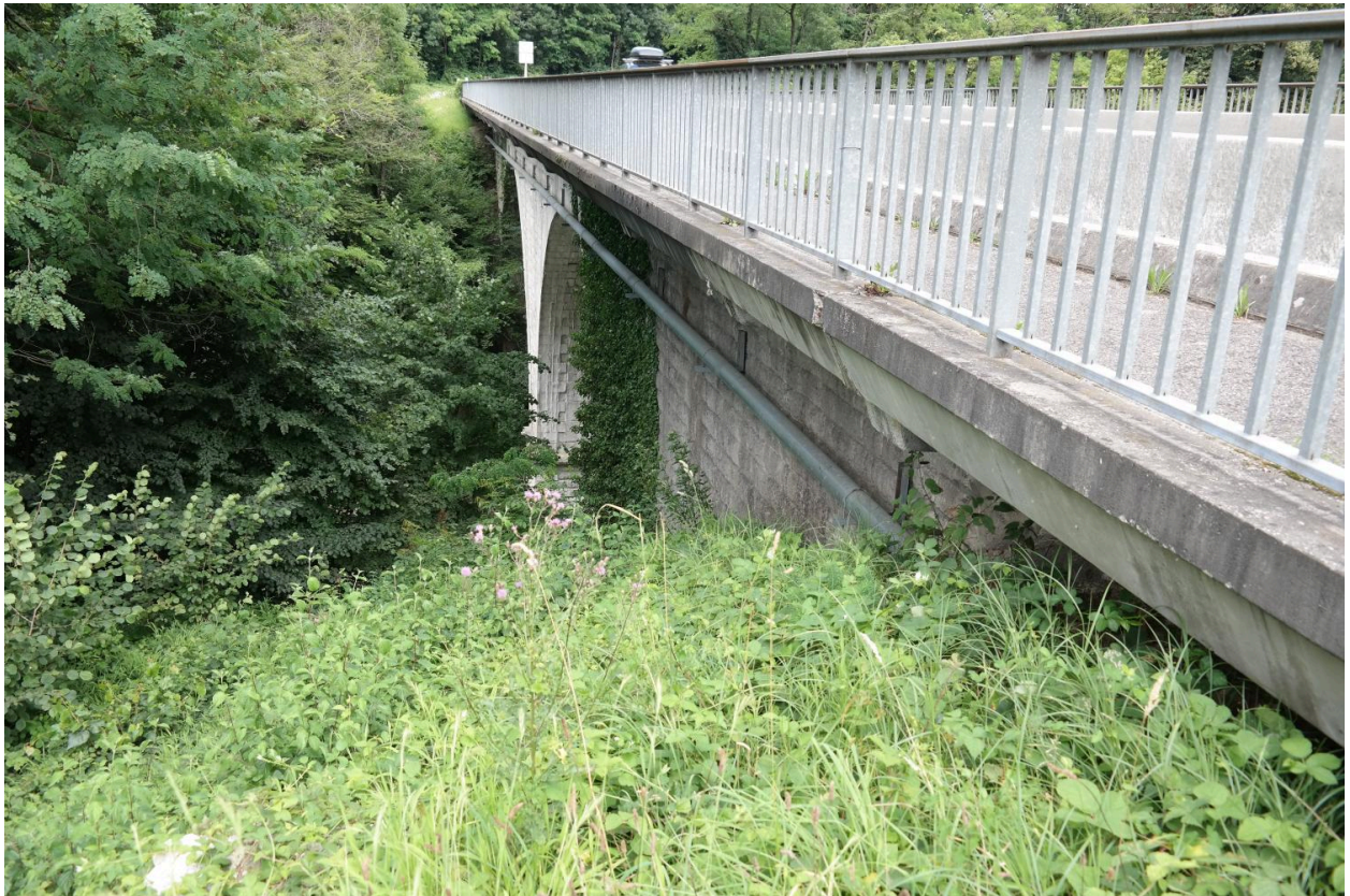
Pont Mottet, vue de la face aval
