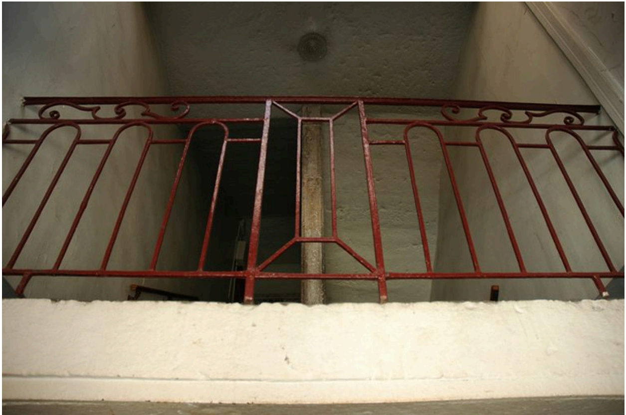
L'escalier : détail du garde-corps des repos
