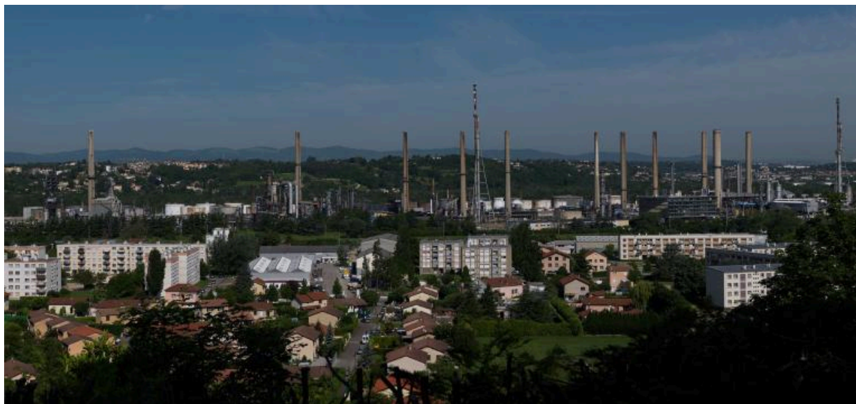
Vue d'ensemble de la raffinerie de Feyzin
