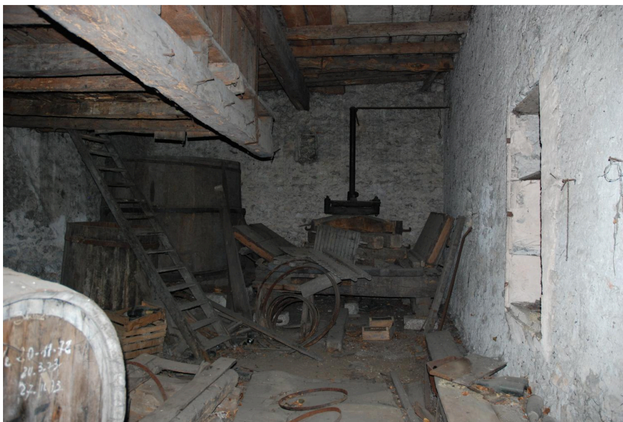
Vue intérieure, rez-de-chaussée : cuvage.
