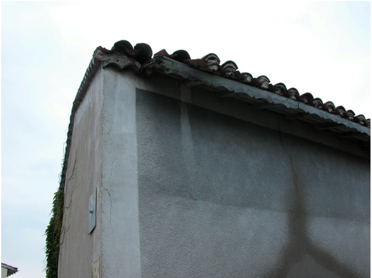
Le Bourg, maison (1988 C 175, 176), non repérée : détail de la bordure de toit.
