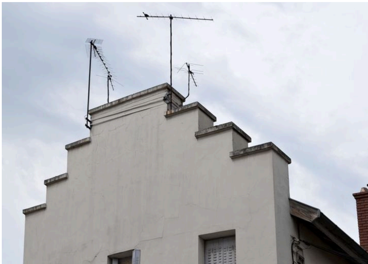
Seconde maison : pignon à redans
