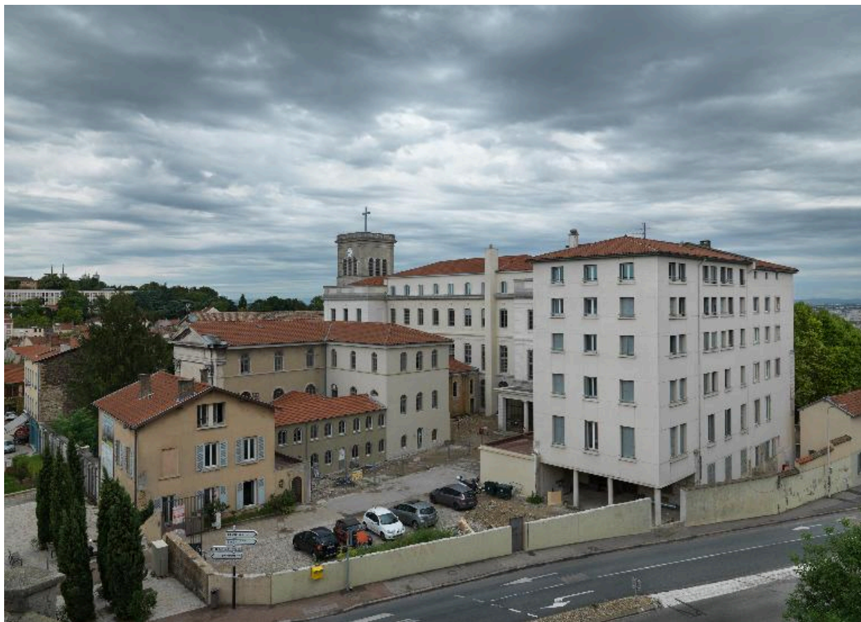
Vue d'ensemble depuis le sud-ouest (depuis le bâtiment "le Vieux Fort" au sein du fort Saint-Irénée construit autour des vestiges de l'aqueduc romain du Gier)
