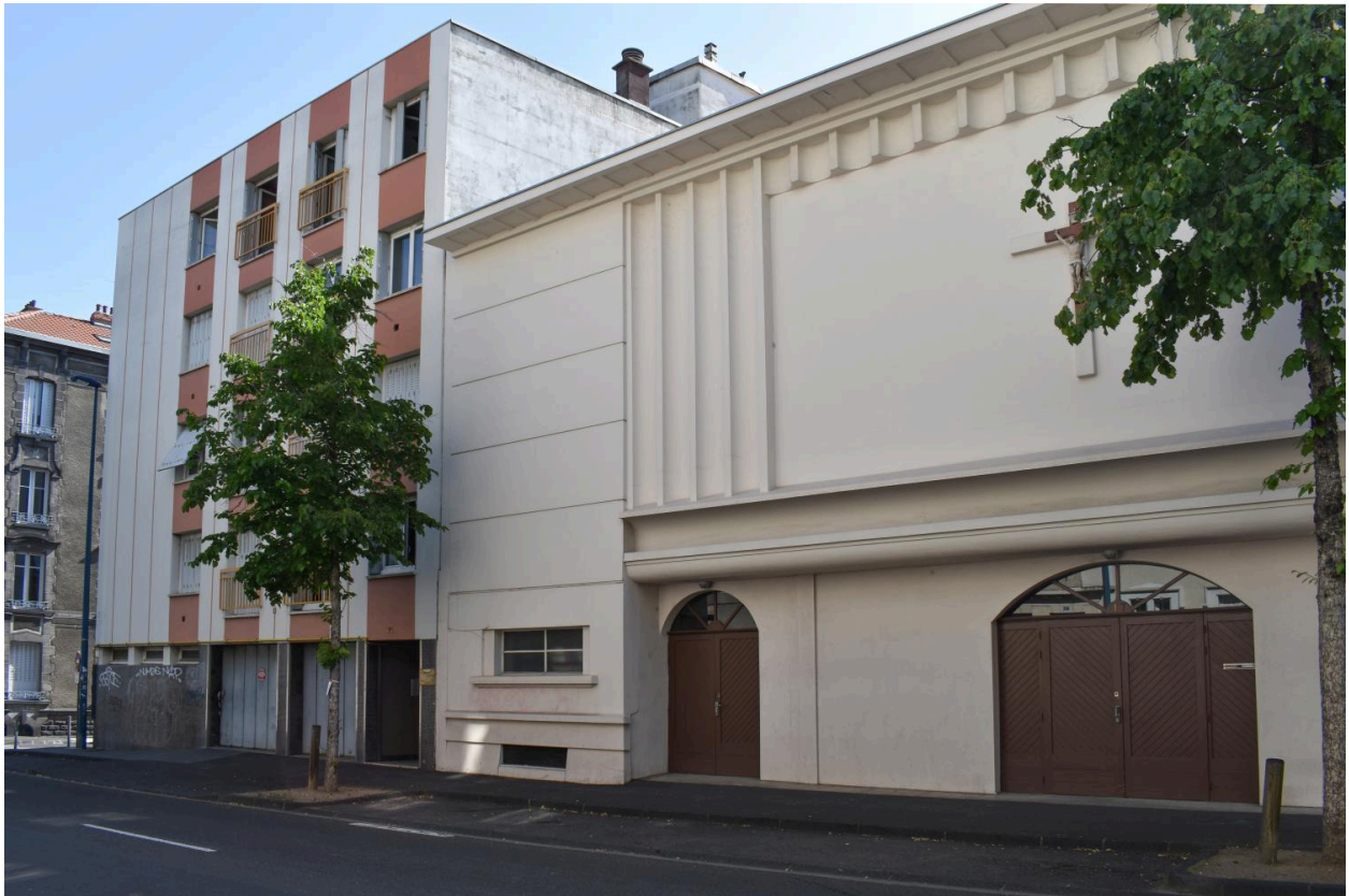
Façade sur l'avenue d'Italie
