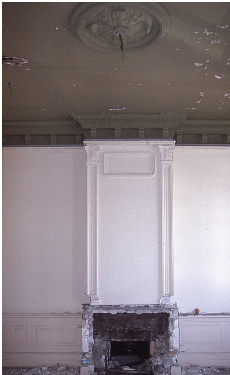
Chenimée du pavillon sud
