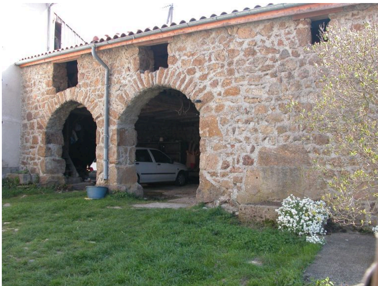
Vue d'ensemble du bâtiment agricole est.
