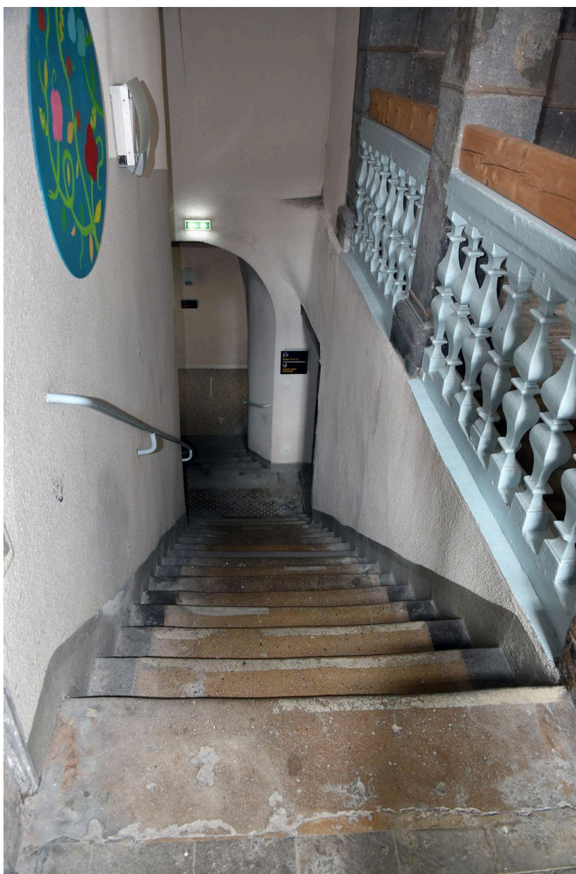
Escalier F : volée entre l'étage de soubassement et le rez-de-chaussée, depuis le haut
