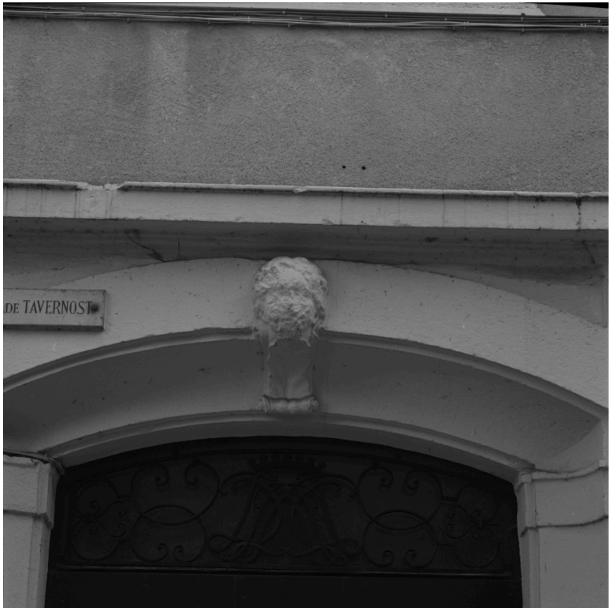
Détail de la porte d'entrée : agrafe (bûchée) et tympan, avec chiffre entrelacé en fer forgé.
