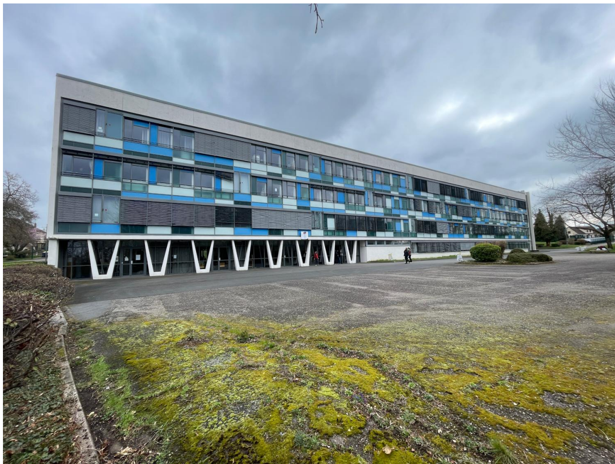
Bâtiment C, vue d'ensemble
