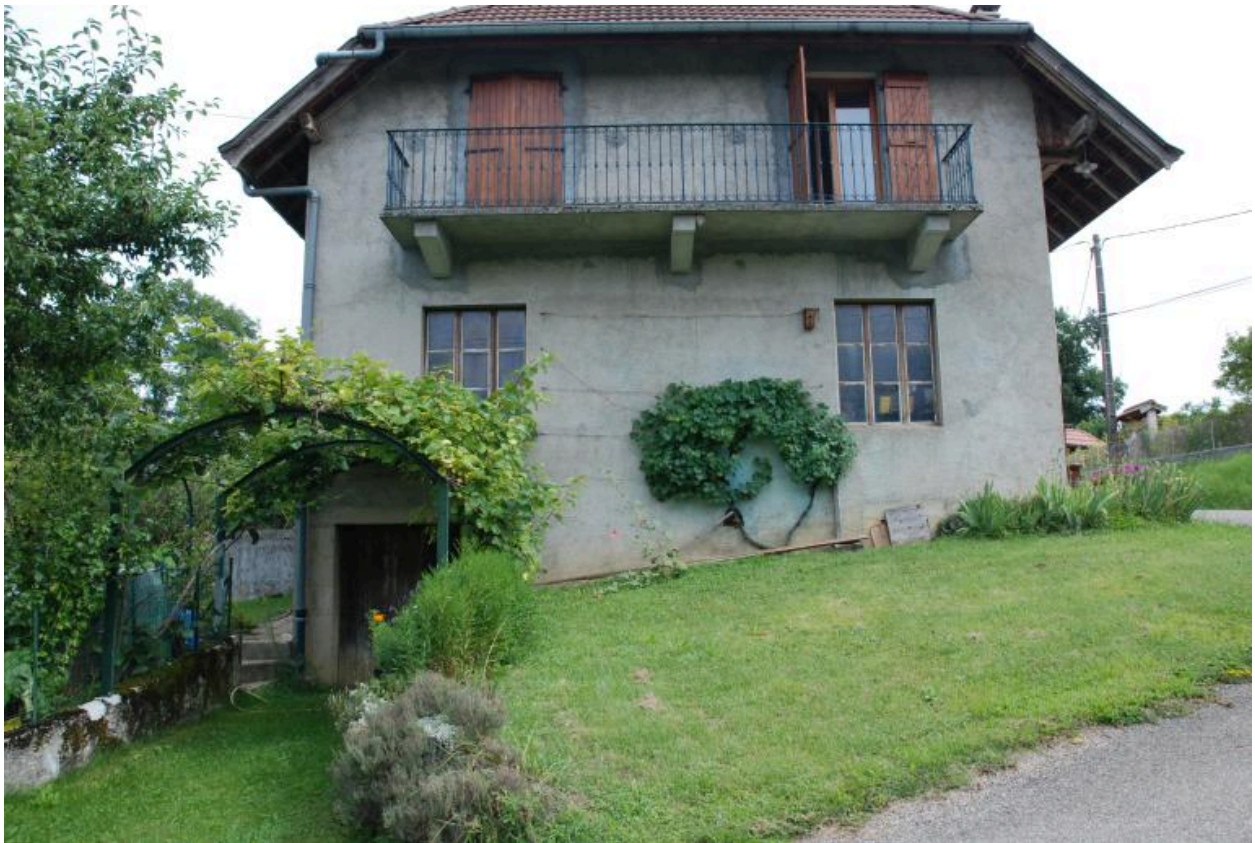
Vue de l'atelier de menuiserie, élévation sud.
