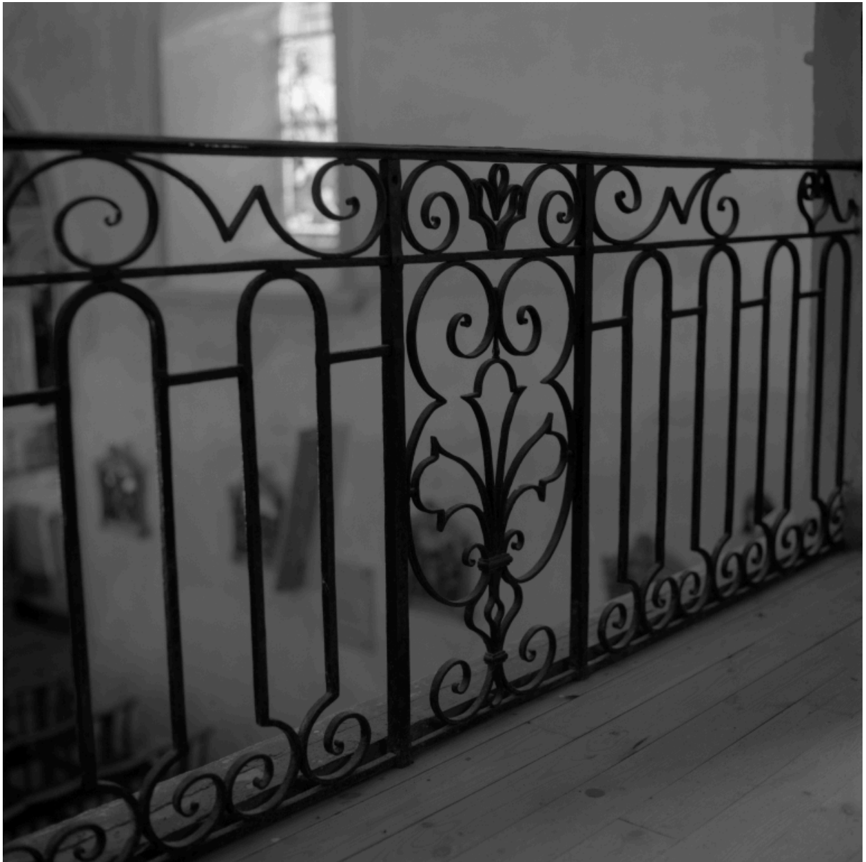
Vue d'ensemble d'une partie du garde-corps de tribune.
