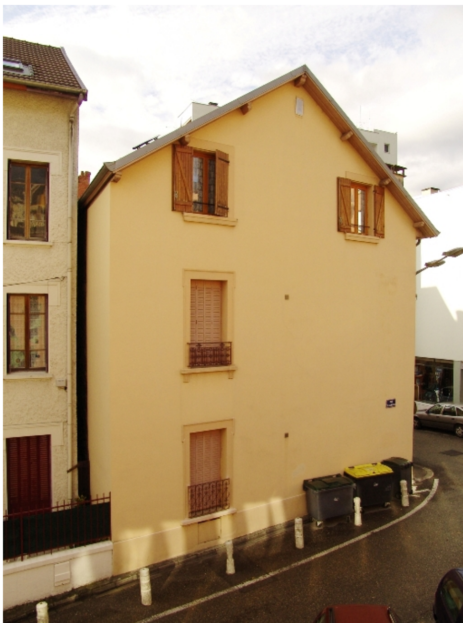
Pignon oriental sur rue
