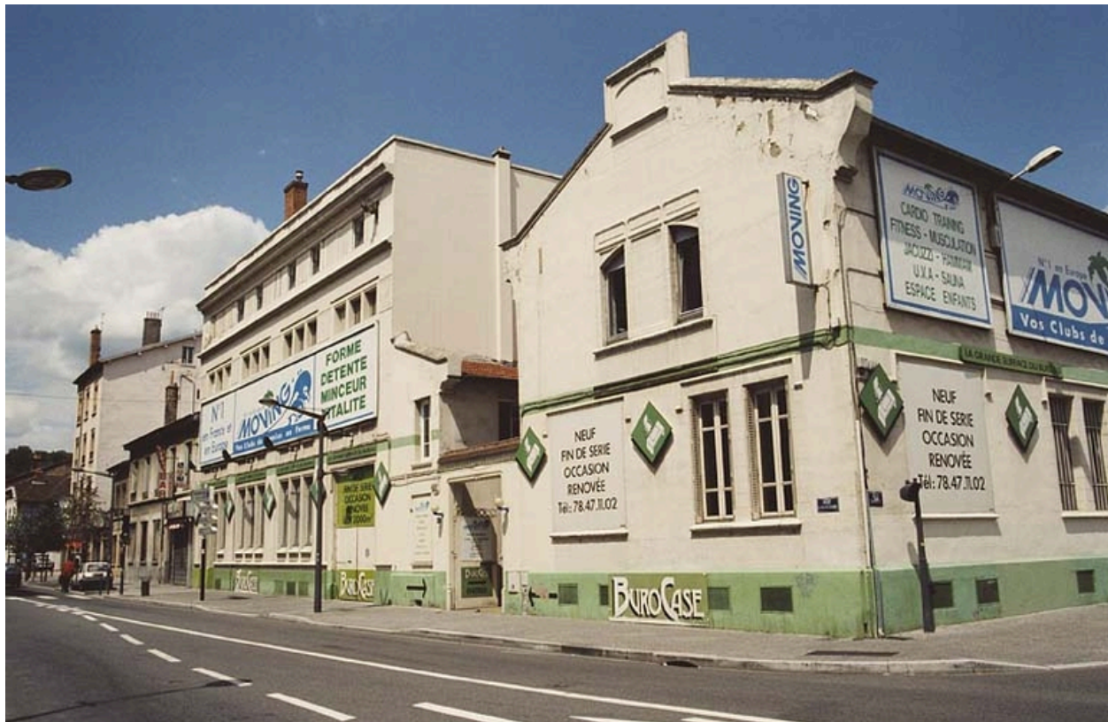
Vue d'ensemble sud-ouest
