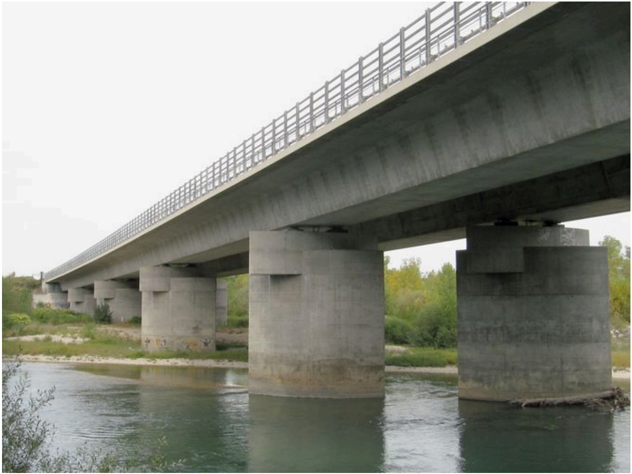
Vue générale de la partie du pont sur le canal de Miribel, face aval (depuis la rive gauche)
