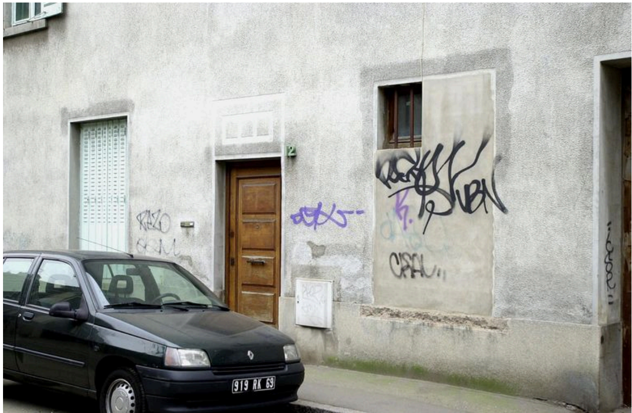
Détail de l'élévation antérieure
