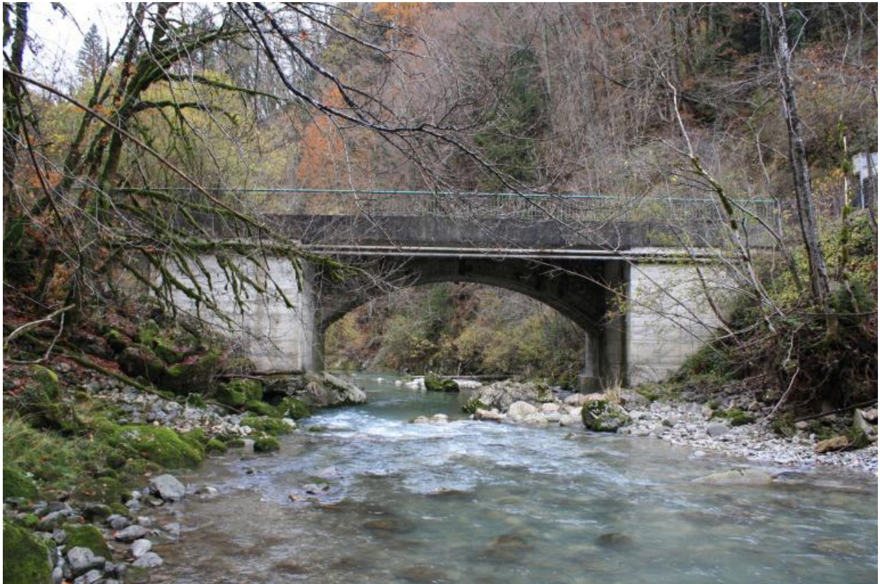
Pont de la Forclaz, face amont
