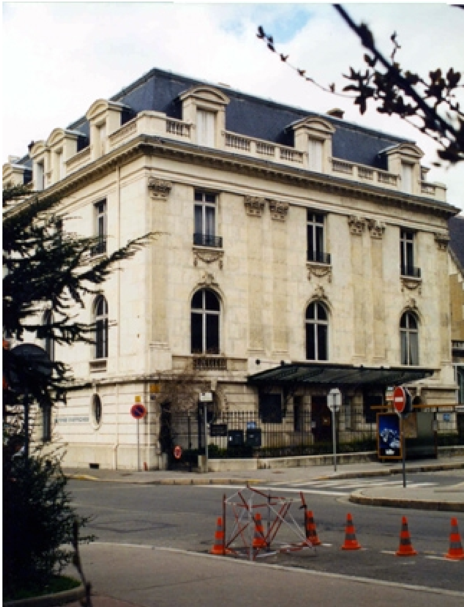
Façade principale, avec sa marquise, rue Lieutenant-Colonel-Morin
