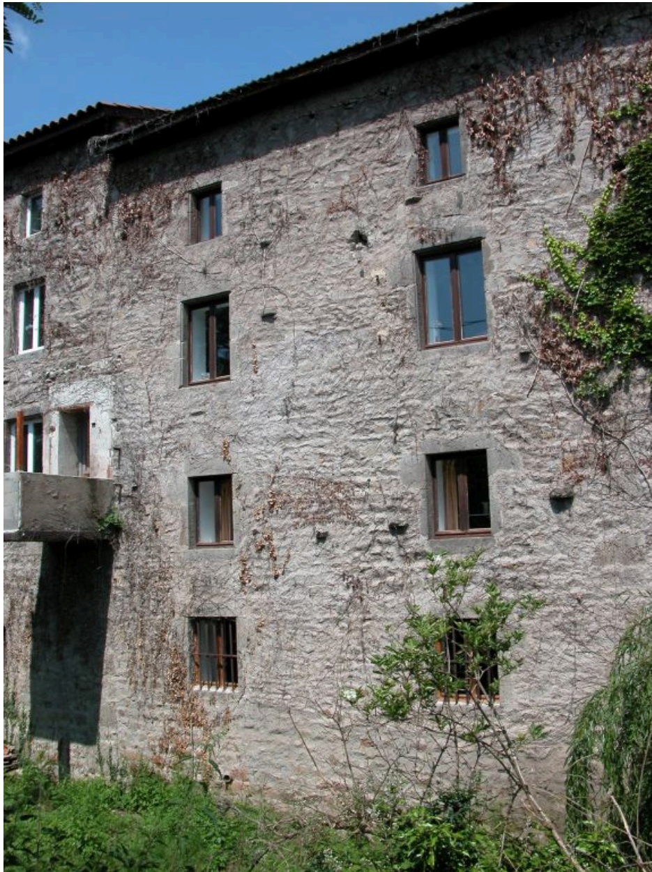
Travées du premier corps de bâtiment, façade sud-est du moulin
