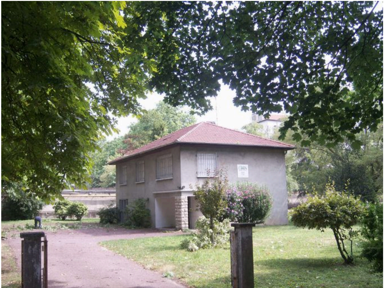
Bâtiment Nord Est, vue générale
