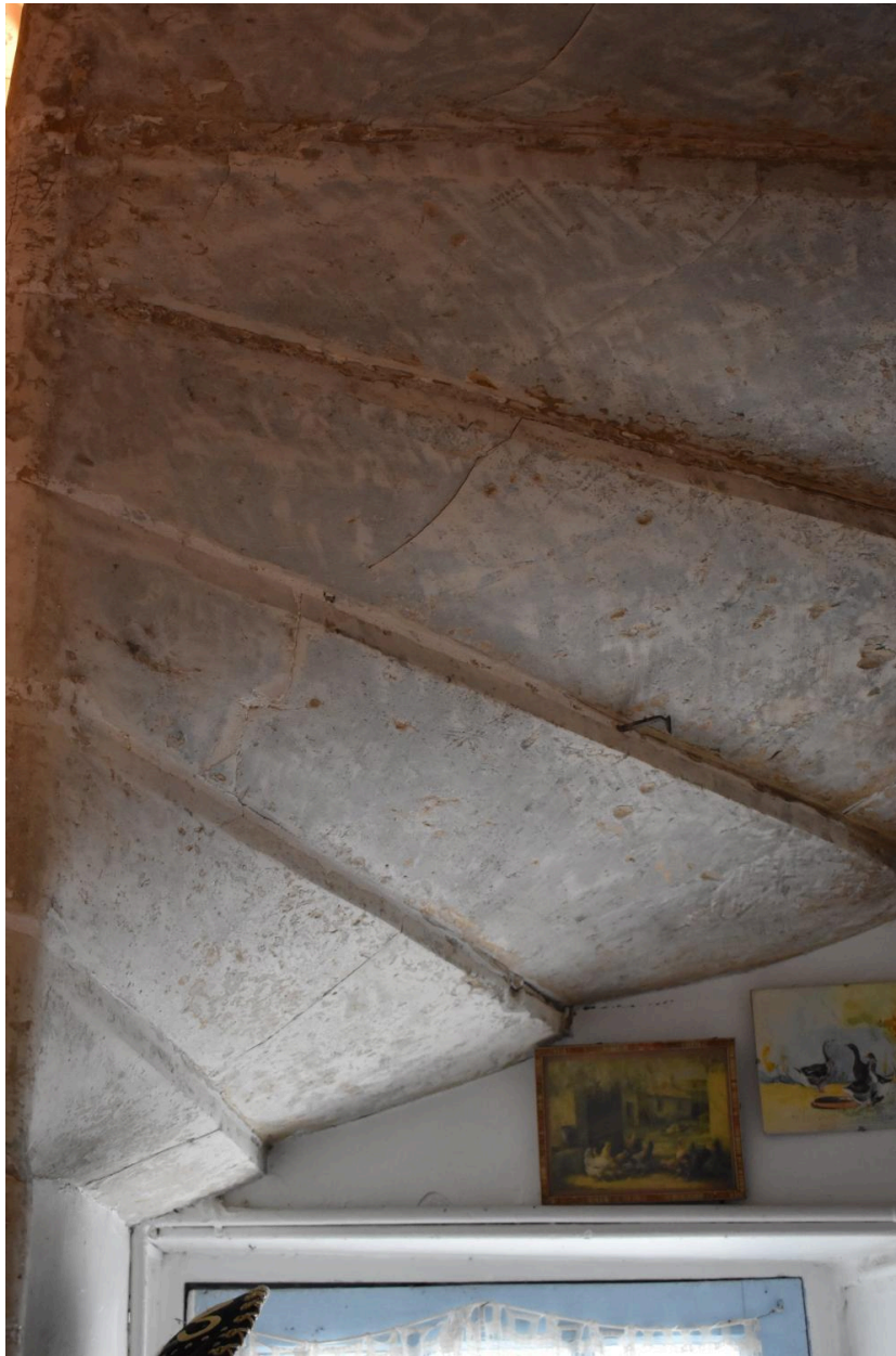
Détail de l'escalier en vis, vue de dessous.
