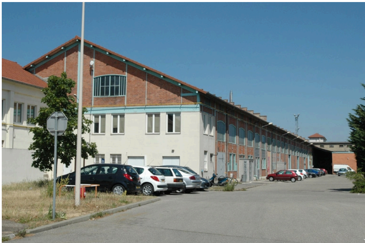
Vue nord des entrepôt (bâtiment n° 15)
