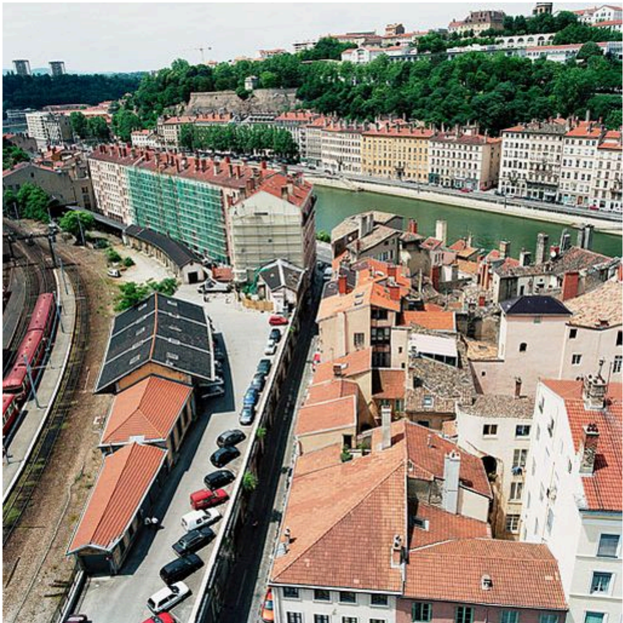
Vue générale des entrepôts
