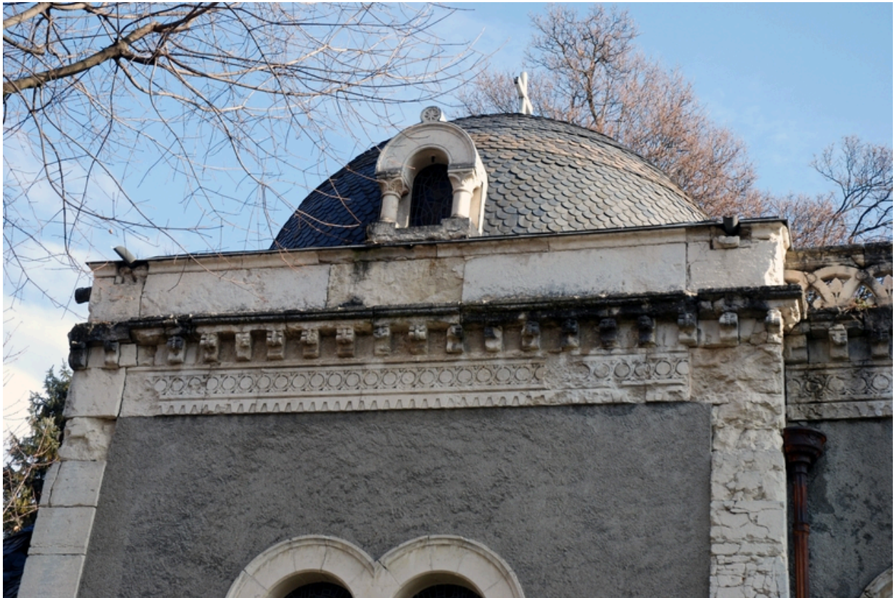
Elévation postérieure, vue partielle
