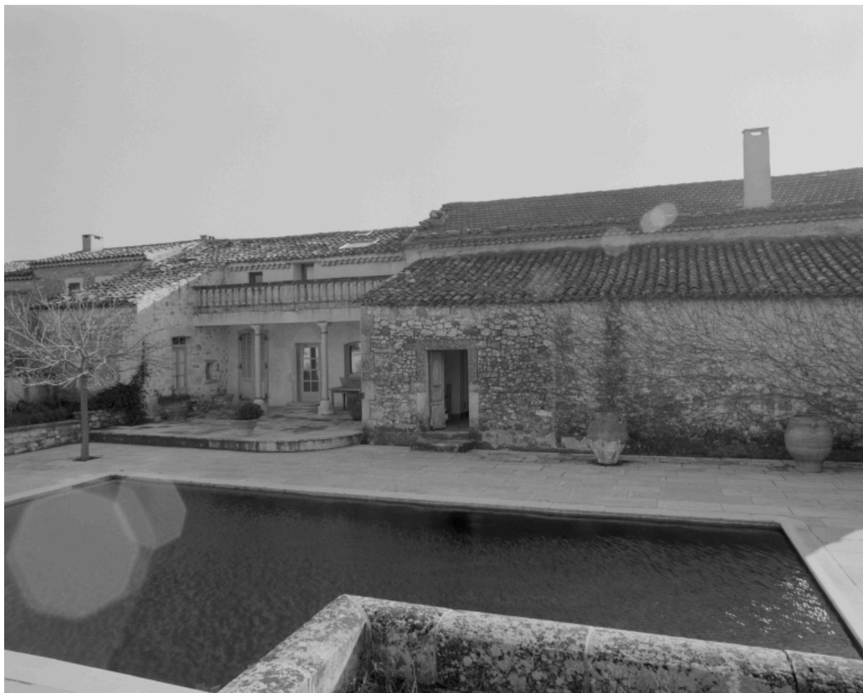
Les Planes (ZC 29). Ferme, élévation postérieure.
