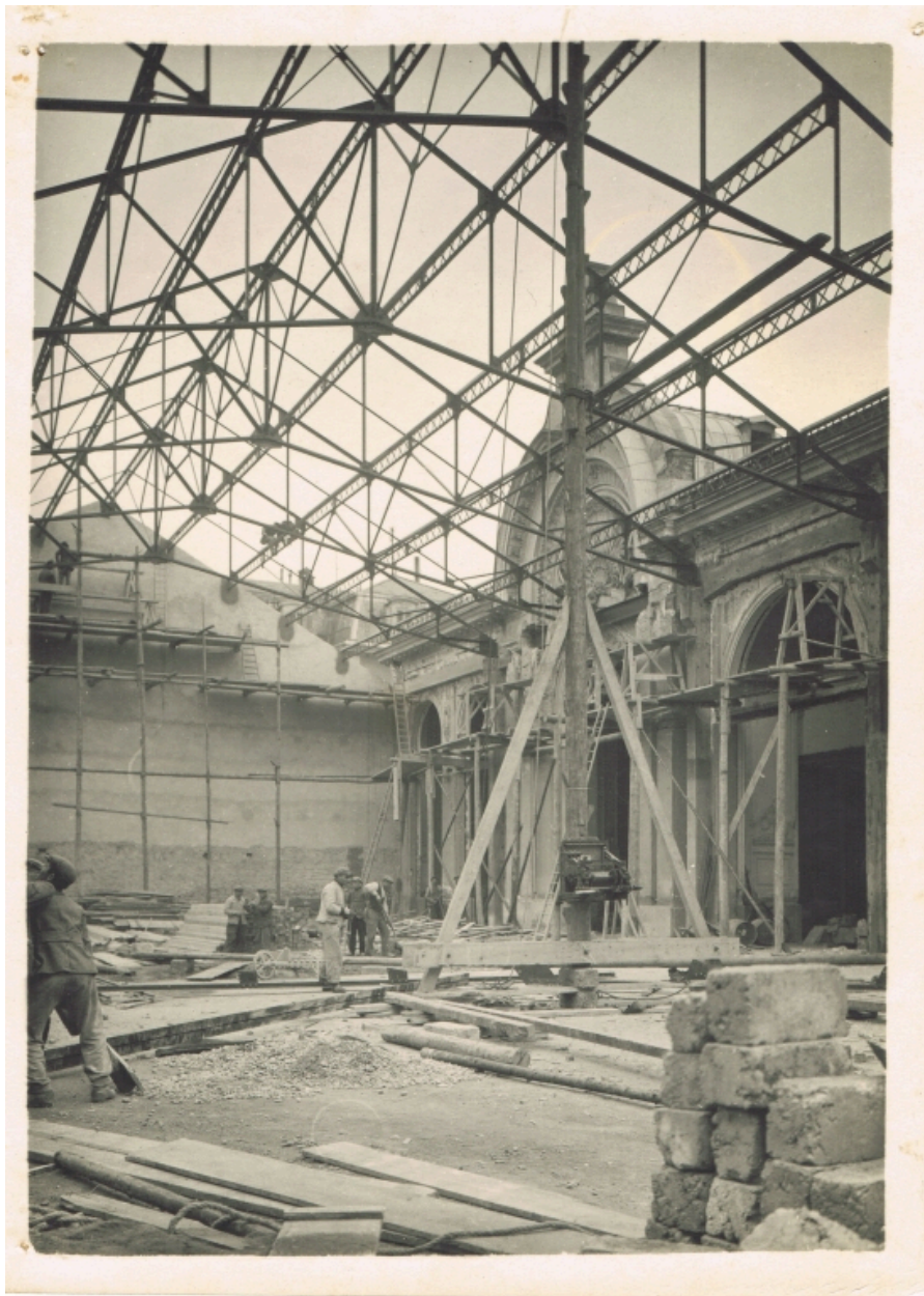
Charpente métallique du garage
