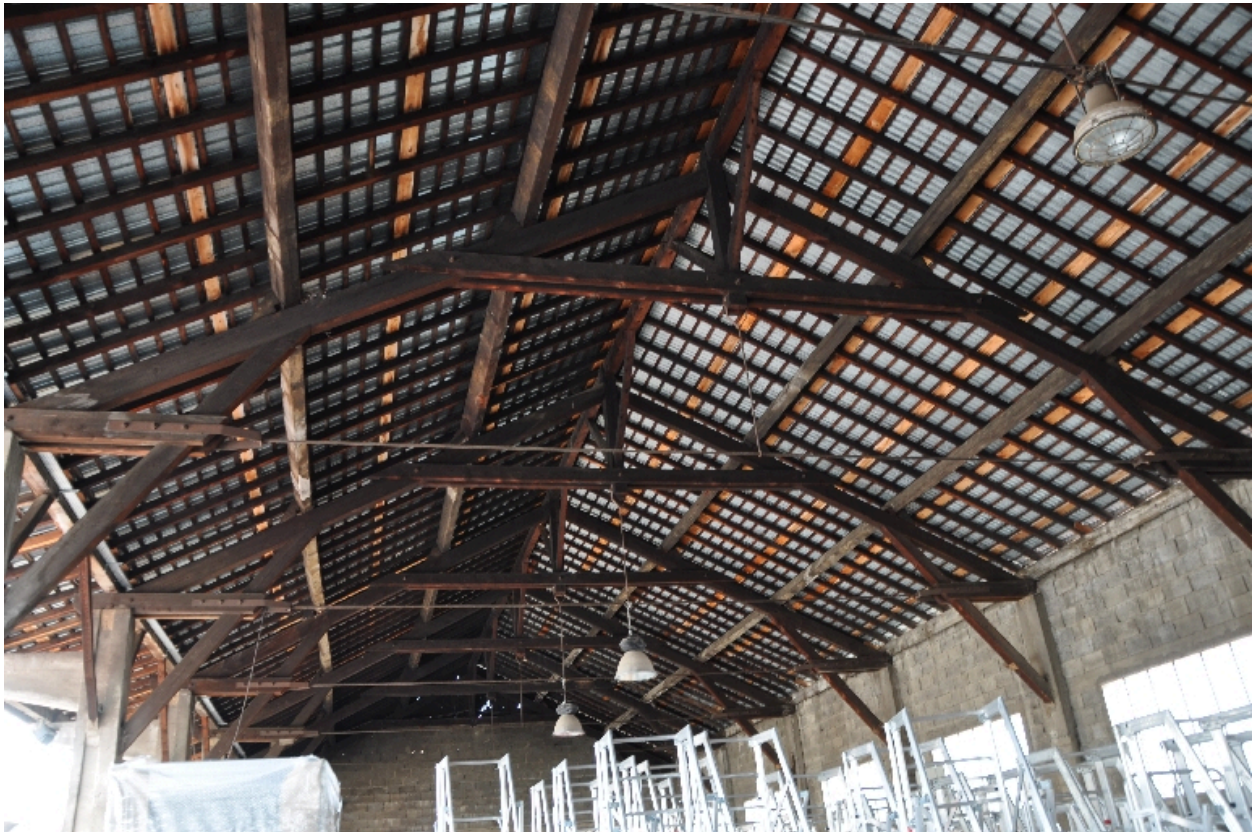
Charpente de l'entrepôt sud
