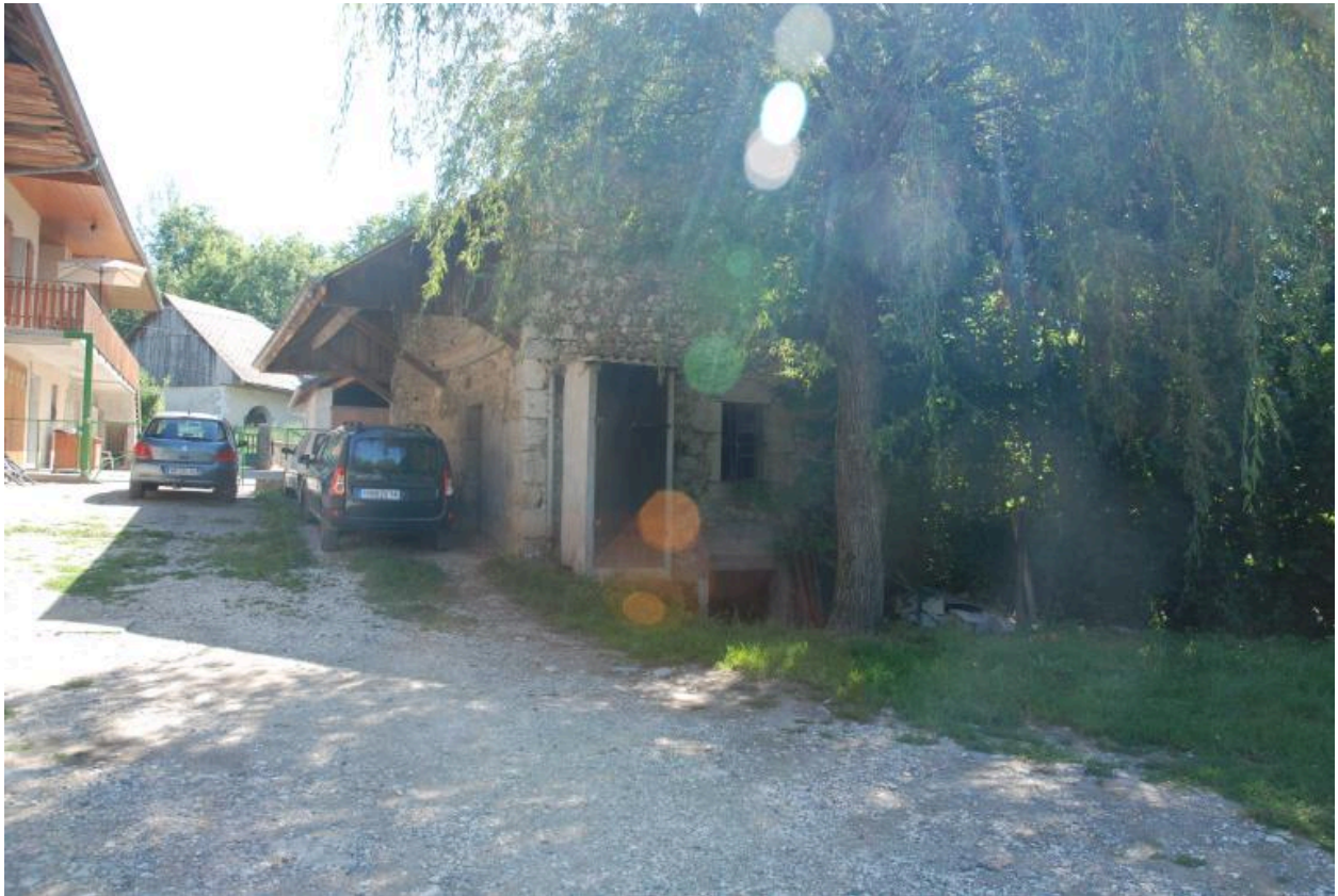
Vue du bâtiment annexe.
