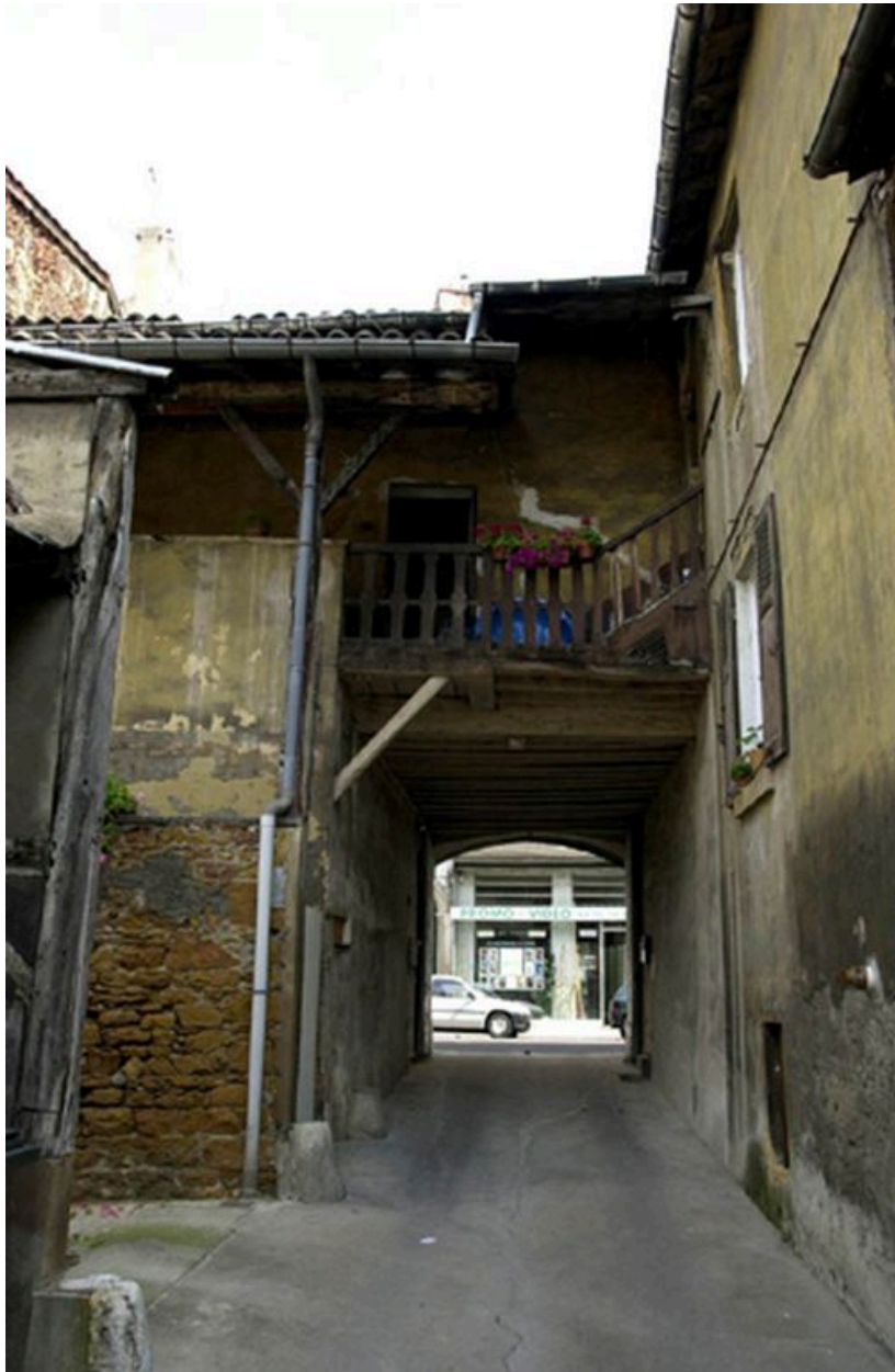
Élévation postérieure du bâtiment sur rue et corps de passage
