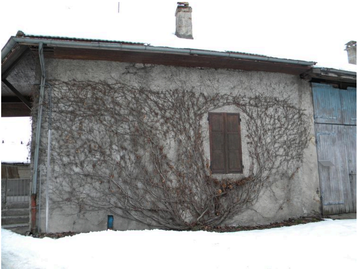
Façade arrière de la ferme.
