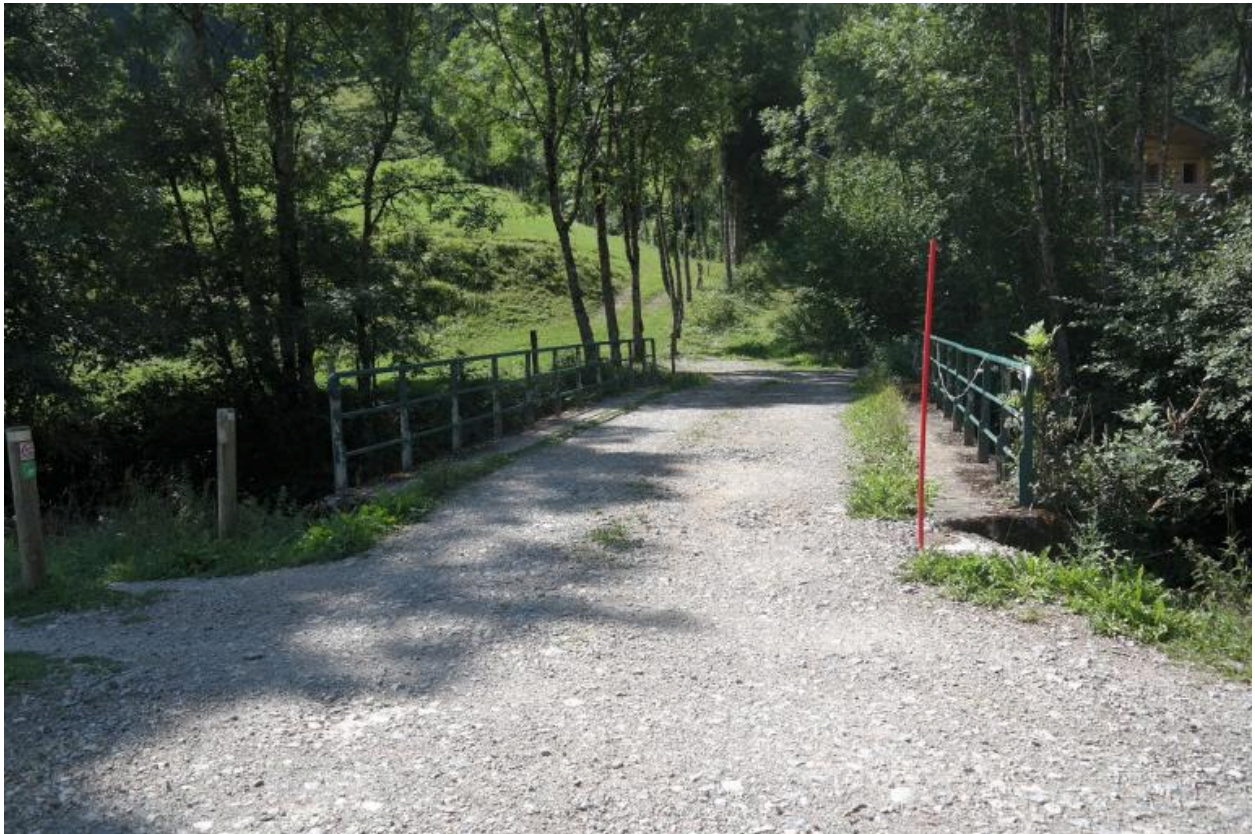
Pont de Passengué, chaussée et rambardes
