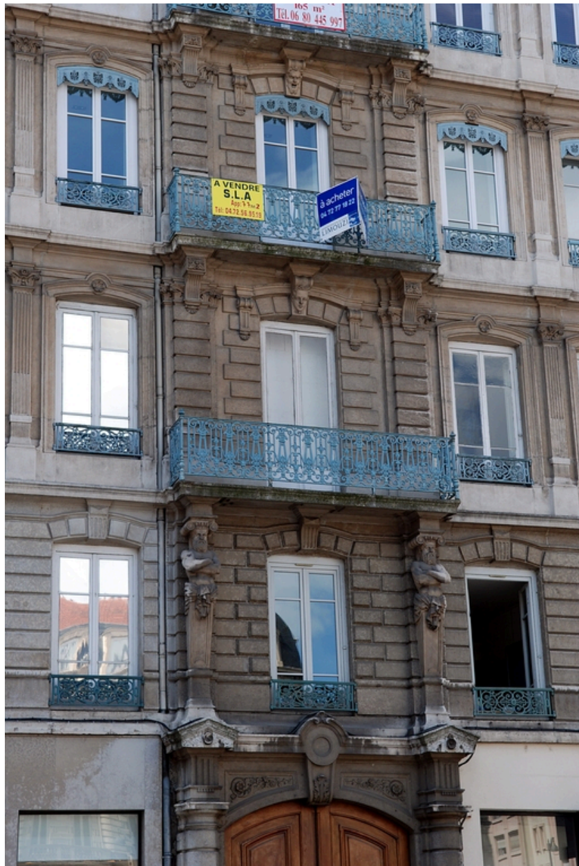
Elévation place des Jacobins : travée axiale
