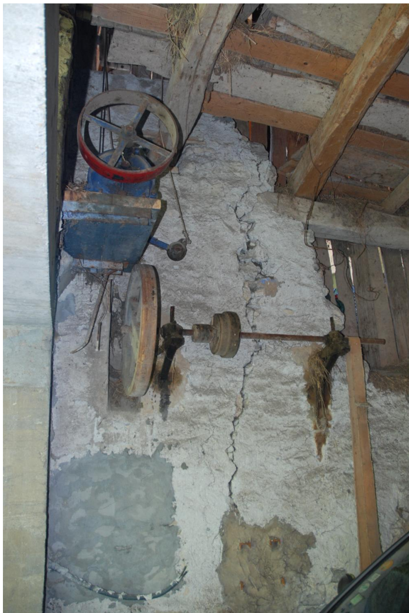
Grange-étable (2018 I1 198), vue du treuil à foin.
