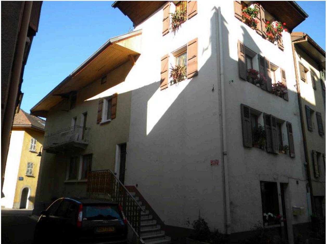
Vue des façades des immeubles passage de la Paquière (2008 D15 2422, 2423, 2425).
