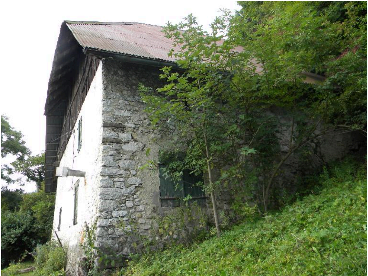
Vue de la façade nord.
