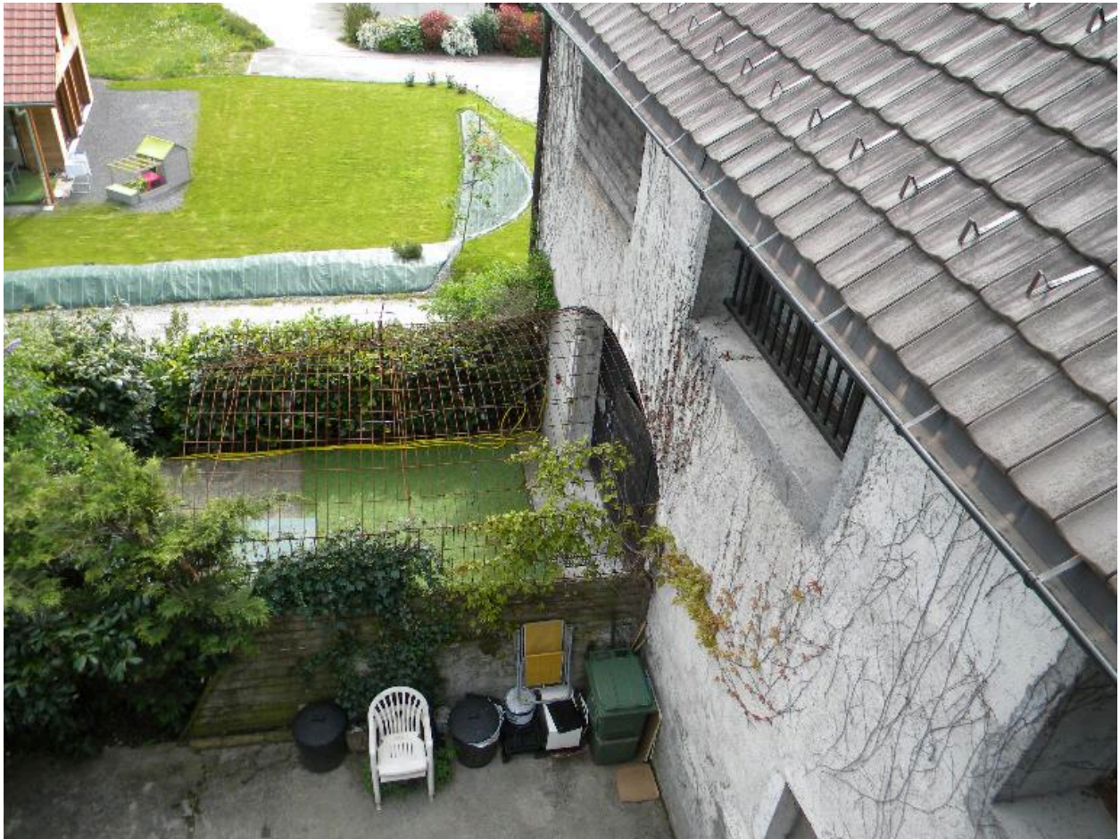
Vue plongeante sur la façade nord.
