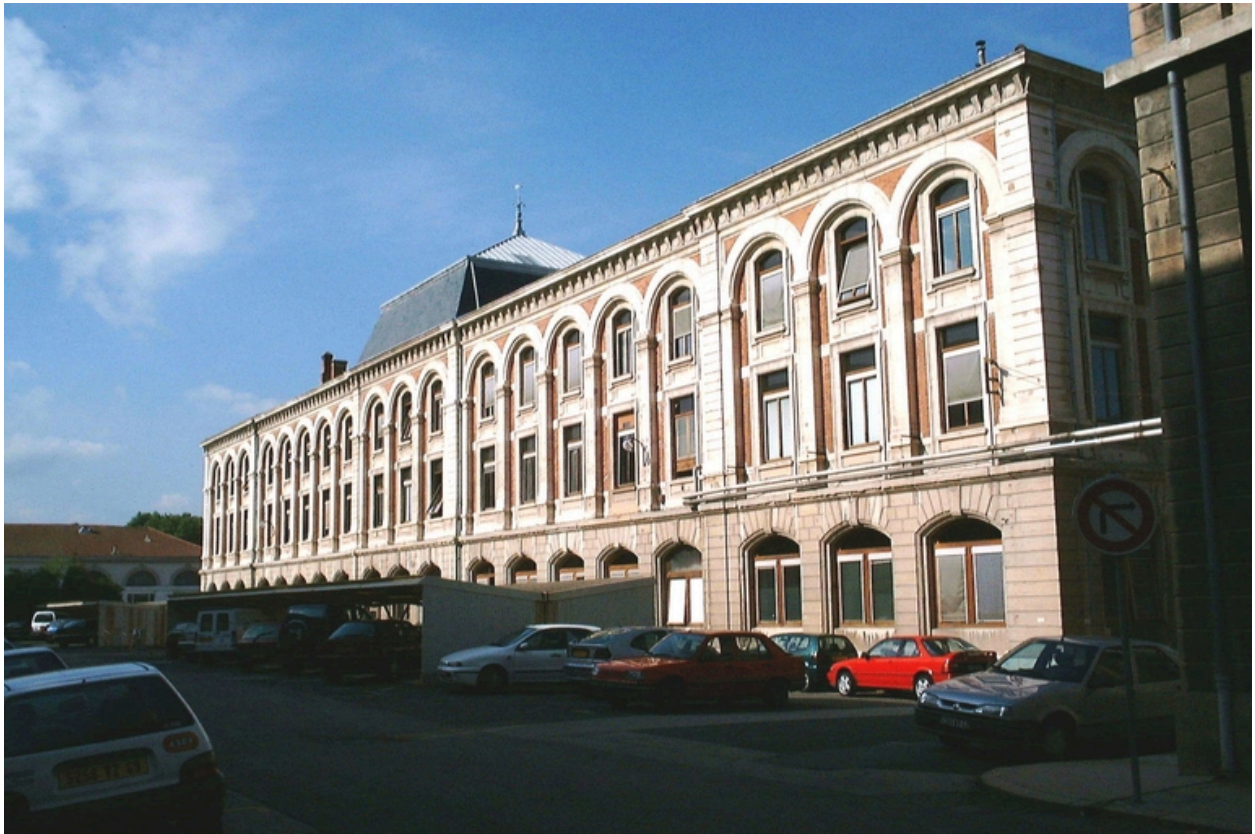
Bâtiment de l'horloge du site de Giat industrie de Saint Etienne
