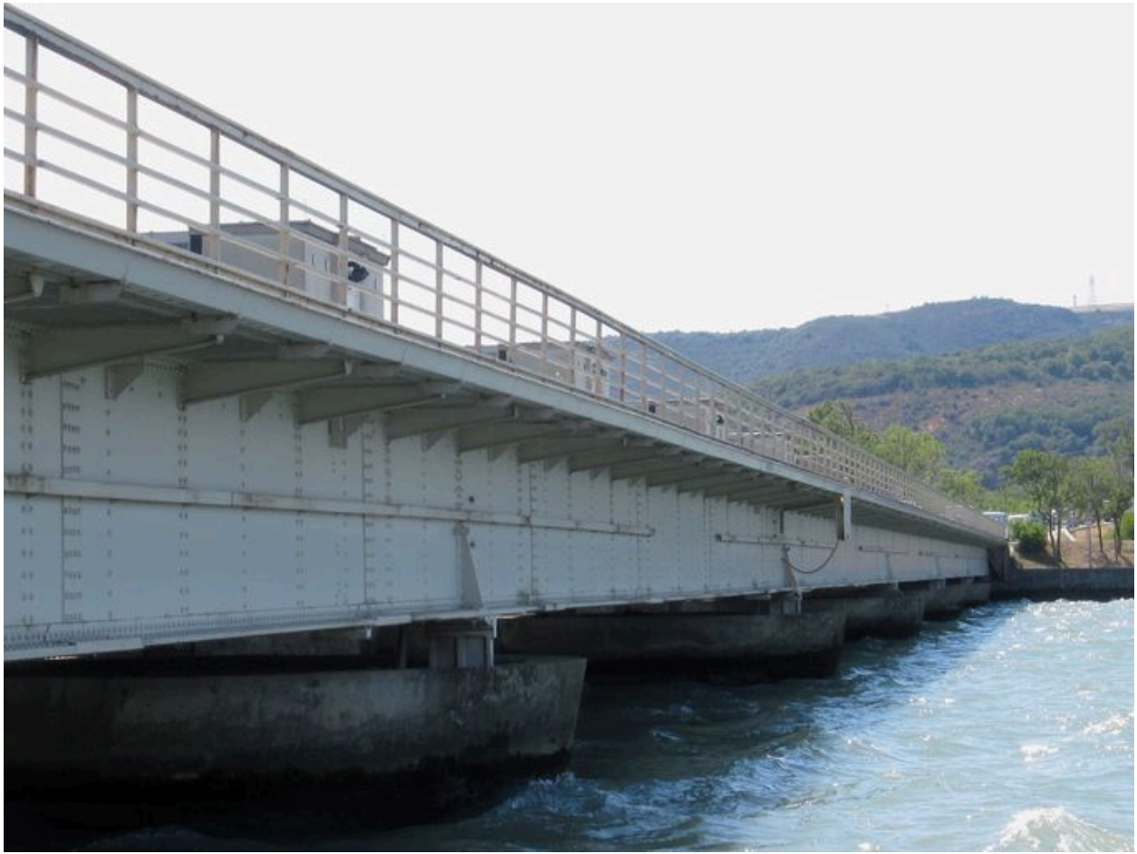
Tablier et parapet du pont routier amont (depuis la rive gauche)
