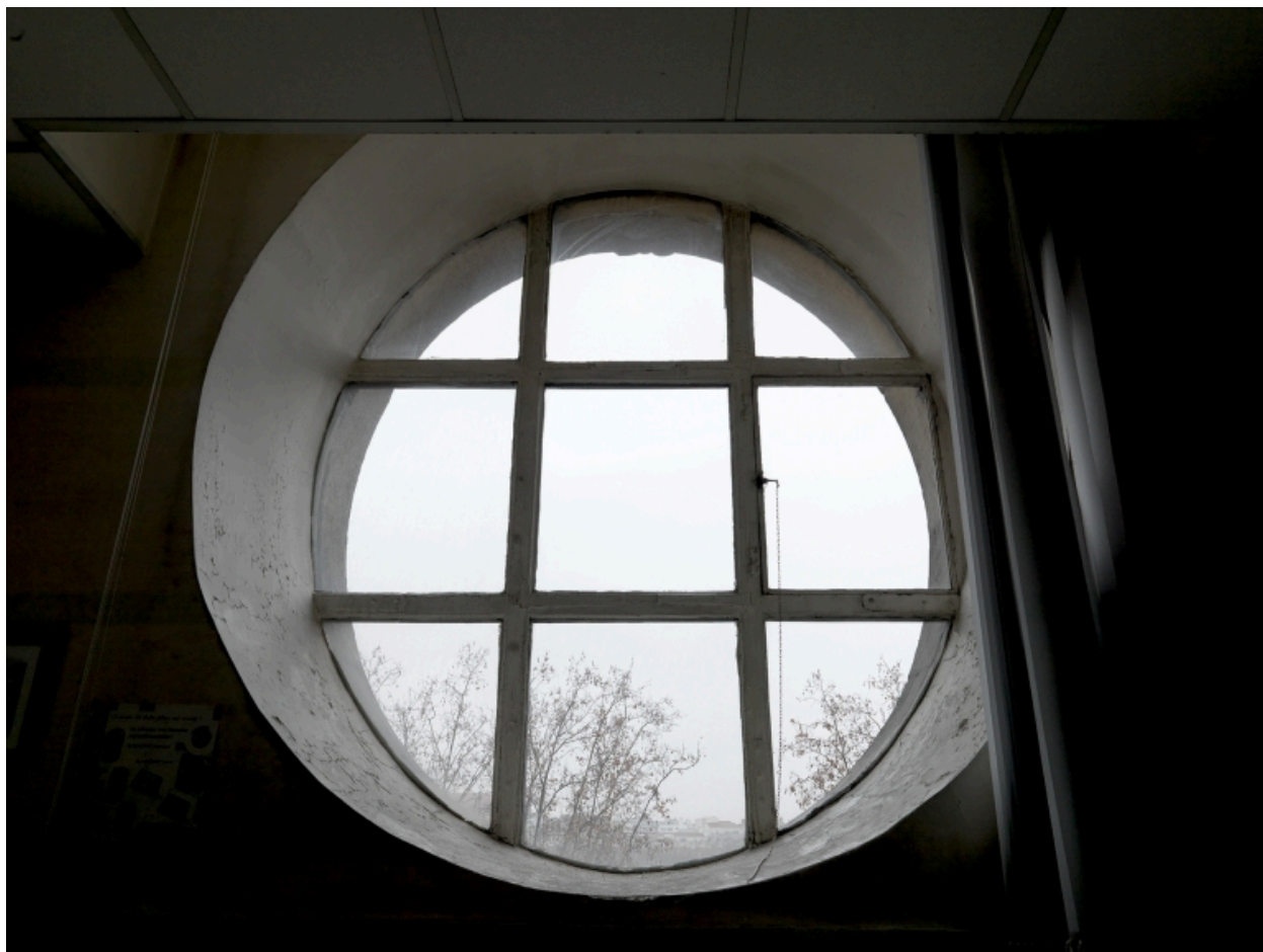
Bâtiment K. Etage Saint-Clair. Oculus au-dessus du passage couvert, côté quai
